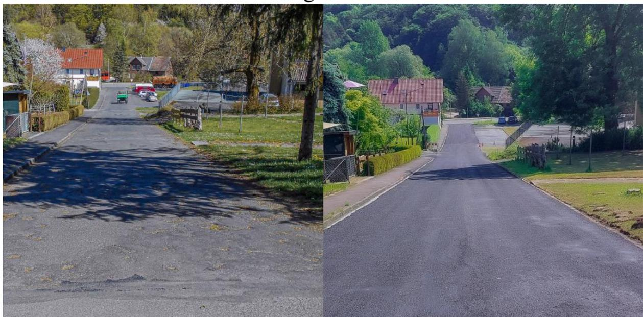
SCHULSTRASSE IN ROMMERODE VOR (LINKS) UND NACH (RECHTS) DER SANIERUNG MIT DEM DSK-VERFAHREN
